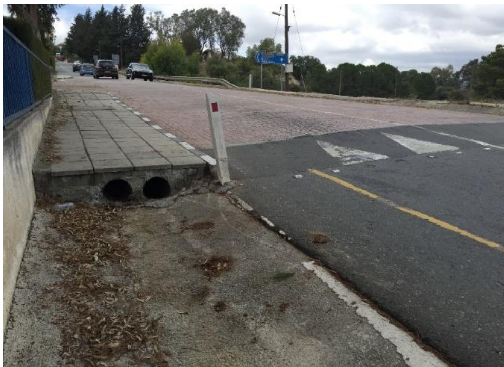
Εικόνα 14: Πλατό οδοστρώματος στην Κύπρο.
