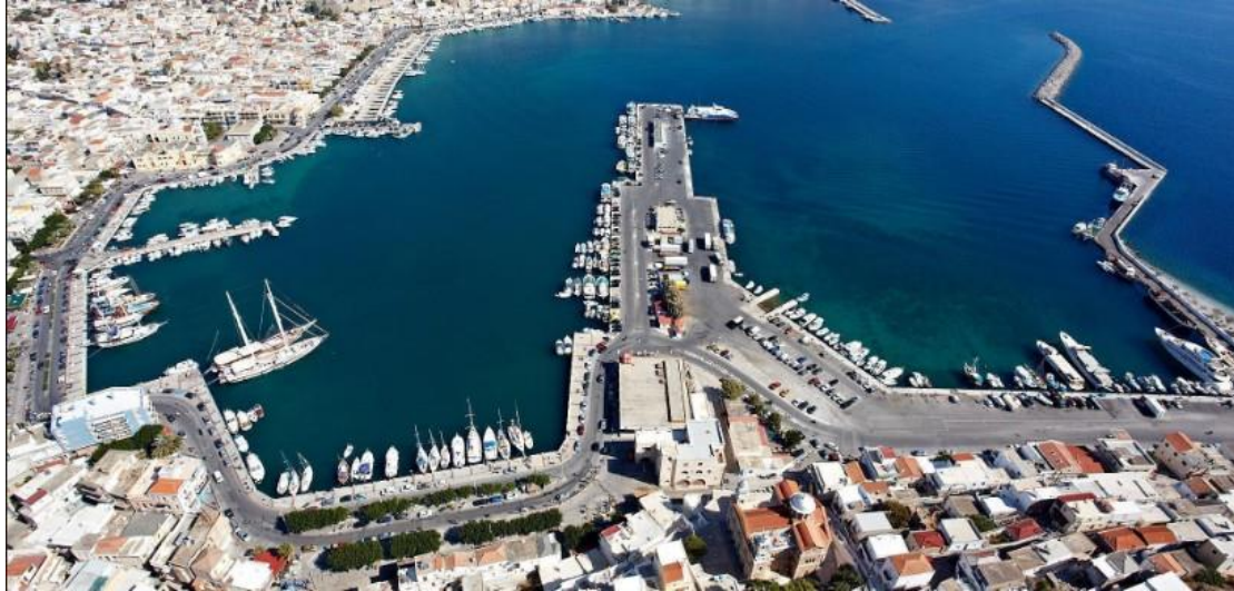
Εικόνα 3: Άποψη λιμένα Καλύμνου.
