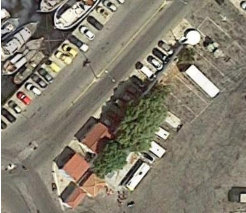
Εικόνα 22: Χώρος στάθμευσης λεωφορείων.
